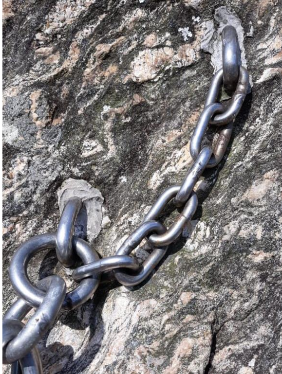
Parada dupla com Wave bolts (químico) da Fixe, corrente e argolas na P1 da Italianos no Pão de Açúcar
